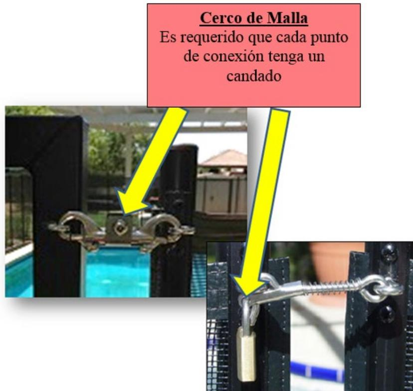
La cerca está asegurada al suelo o tiene suficiente tensión para evitar que se levante más de 4 pulgadas desde el suelo en todos los puntos.
