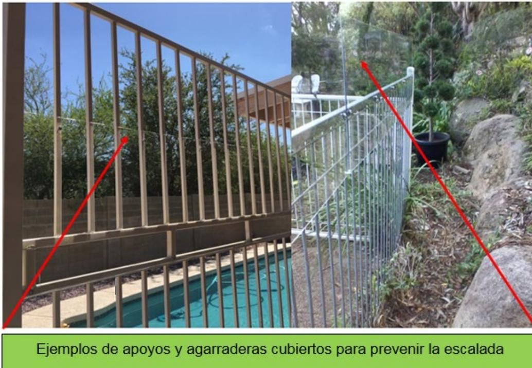
Si el cerramiento esta construido de cadena, celosía, malla o cualquier otro material similar las aberturas deben medir menos de 1 ¾ pulgadas (medido horizontalmente)
